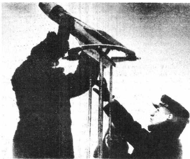
Монтаж второй ступени ракеты с прямоточным двигателем на пусковой установке (справа — И. А. Меркулов). Март 1939 г.
