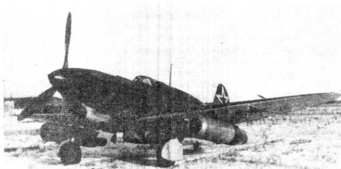
Истребитель Як-7 с прямоточным двигателем ДМ-4с. Февраль 1944 г.
